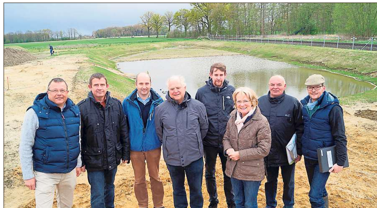
Ein Regenrückhaltebecken soll am neuen Baugebiet Liesborn-Kirchhusen entstehen. Das Bild zeigt (v. l.) Bürgermeister Christian Thegelkamp, Rudolf Luster Haggeney, Klaus Grothues, Heiner Sonnek, Andreas Allemöller, Hannelie Böcker-Riese, Heiner Sudkamp und Matthias Wehmeier. Bild: Wilmsen
